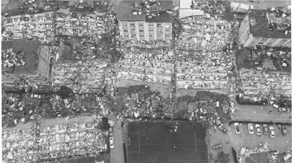
Рис. 3. Последствия землетрясения в Турции в 2023 г.
